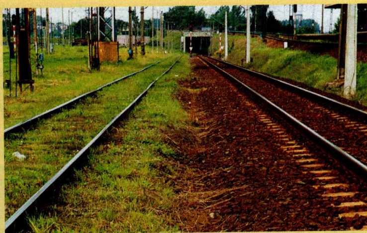
Dwa tory główne: z lewej zachwaszczony, dawno nie remontowany; z prawej – czysta podsyпка kilka lat po naprawie głównej.
