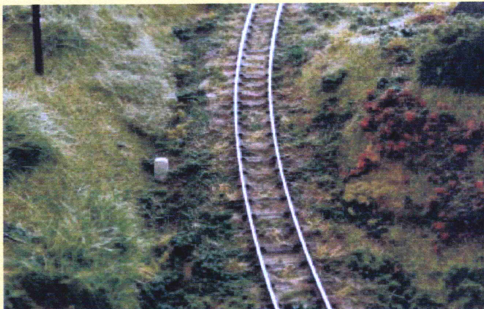
Fot. 3. Fragment szlaku kolej wąskotorowej. Charakterystyczne zachwaszczenia żwirowej podsypki i rowów bocznych wykonanych wzdłuż torowiska.
