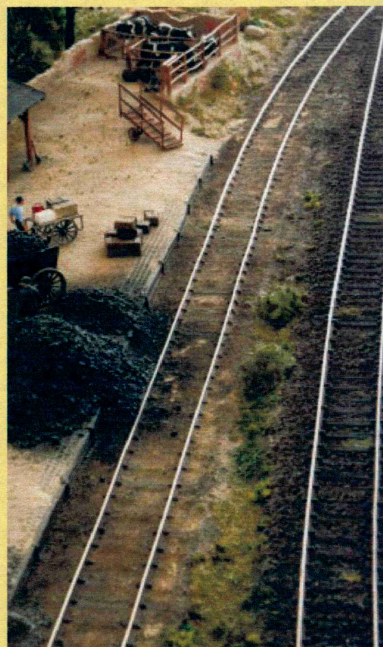
Fot. 1. Tor ładunkowy na podsypce żwirowej. Brak zachwaszczenia świadczy o jego należyтым utrzymaniu, zaś przebarwienia podsypki są efektem różnorodnych usypów z przeładowywanych materiałów.
