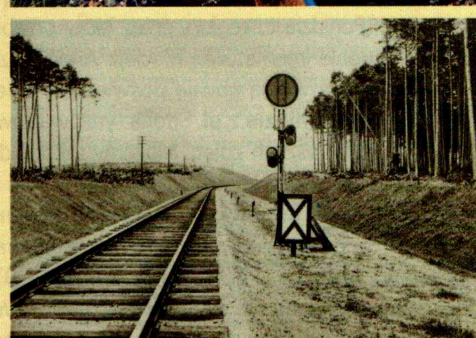
Fot. 1. Tory kolejowe w oryginale:
