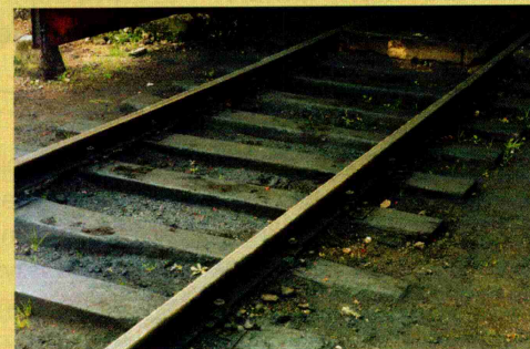
Tory trakcyjne z charakterystycznymi zabrudzeniami podsypki smarem i olejami.
