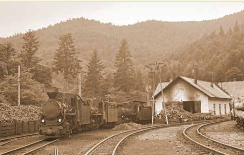
Majdan bei Cisna war Betriebsmittelpunkt und Standort des zentralen Lokbahnhofs für die KP 4-Loks. Infolge der Zerstörungen in den Jahren nach 1945 hatte man hier vieles neu bauen müssen.
