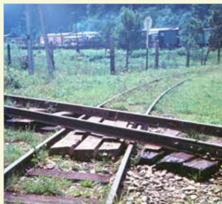
Provisorien halten lange: Eigentlich war diese kuriose Gleiskreuzung nur fliegend (vorübergehend) gedacht, doch schon wächst wieder Gras ...
