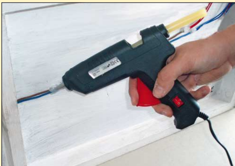
Fot. 5. Mocowanie przewodów przy użyciu pistoletu z klejem termoplastycznym.
