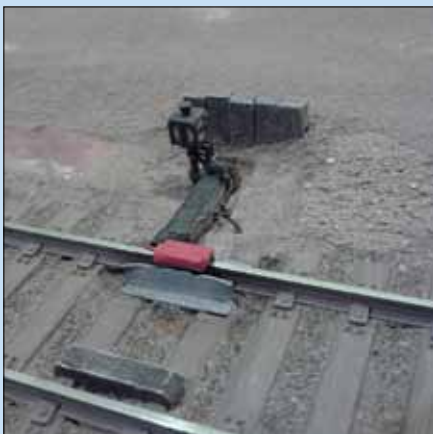
Oben und oben rechts: Während für das durchgehende Streckengleis (im oberen Foto rechts) eine „hohe“ Schotterbettung charakteristisch ist, genügt für das Nebengleis eine vergleichsweise flache Kiesbettung. Deutlich ist die Aussparung für den Bau der Seitenrampe am Gleisende erkennbar.
