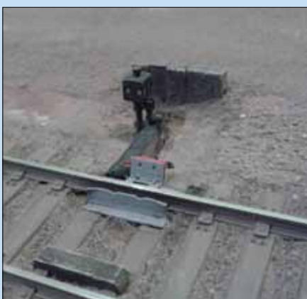
Links: Die Gleissperre im geöffneten und (darüber) im geschlossenen Zustand. Ihre Bedienung erfolgt über einen Mechanismus aus der Zentralverriegelung eines Pkw.
